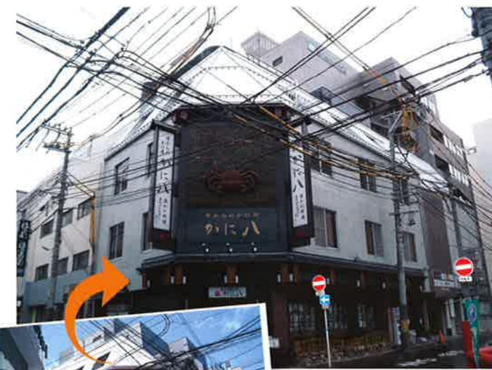
GCPコートによる打放し模様(意匠)の新設 既存:RC面と珪性タイル仕上 (仙台市内・店舗外壁)
