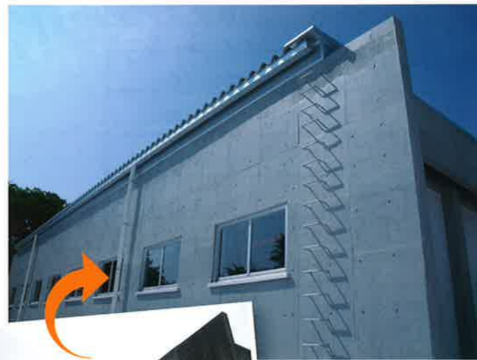
GCPコートによる打放し仕上の復元 既存:コンクリート打放し面 (東北大学・工学部)
