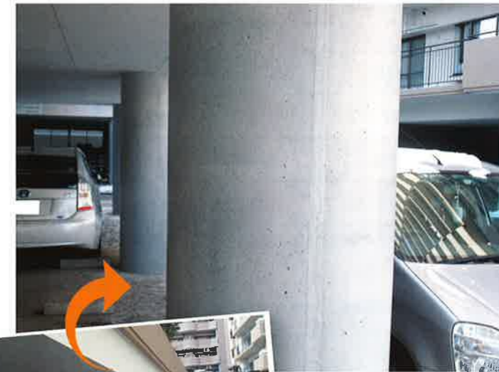
GCPコートによる下地補修跡の復元 既存:コンクリート打放し面 (マンション丸柱)
