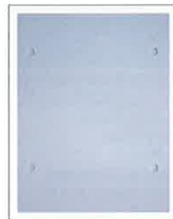
②ベース色塗り 下塗り乾燥後は、ベース色を全面塗装し、下地を完全に隠ぺいします。
