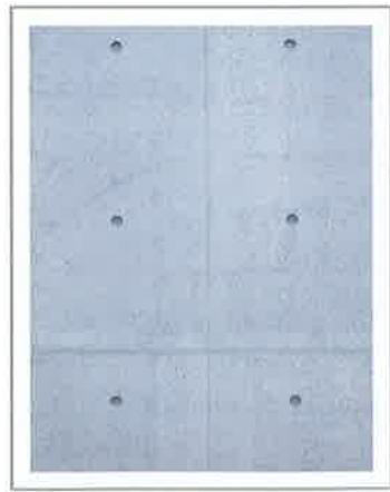
⑤完成 セパレーター補修跡や目遣いも書き込み完成です。
